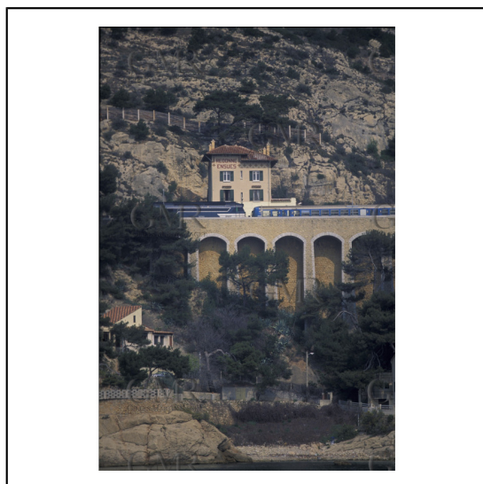
Ensues-la-Redonne - Côte Bleue - Provence***Ensues-la-Redonne - Côte Bleue - Provence
