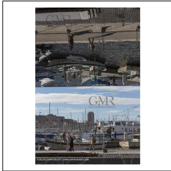
04/02/2013 - Marseille (FRA,13) - Renovation du Quai de la Fraternité (Vieux Port), pose de l'ombrière***04/02/2013 - Marseille (FRA,13) - Vieux Port (historical port) refit - Works on the shadow maker
