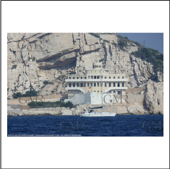
Marseille port, sation des pilotes des iles du Frioul***Marseille port, Pilot station at Iles du Frioul
