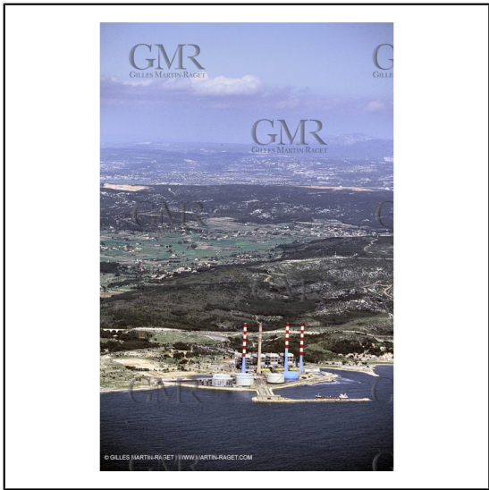
Centrale électrique de Carteau***Carteau electric plant
